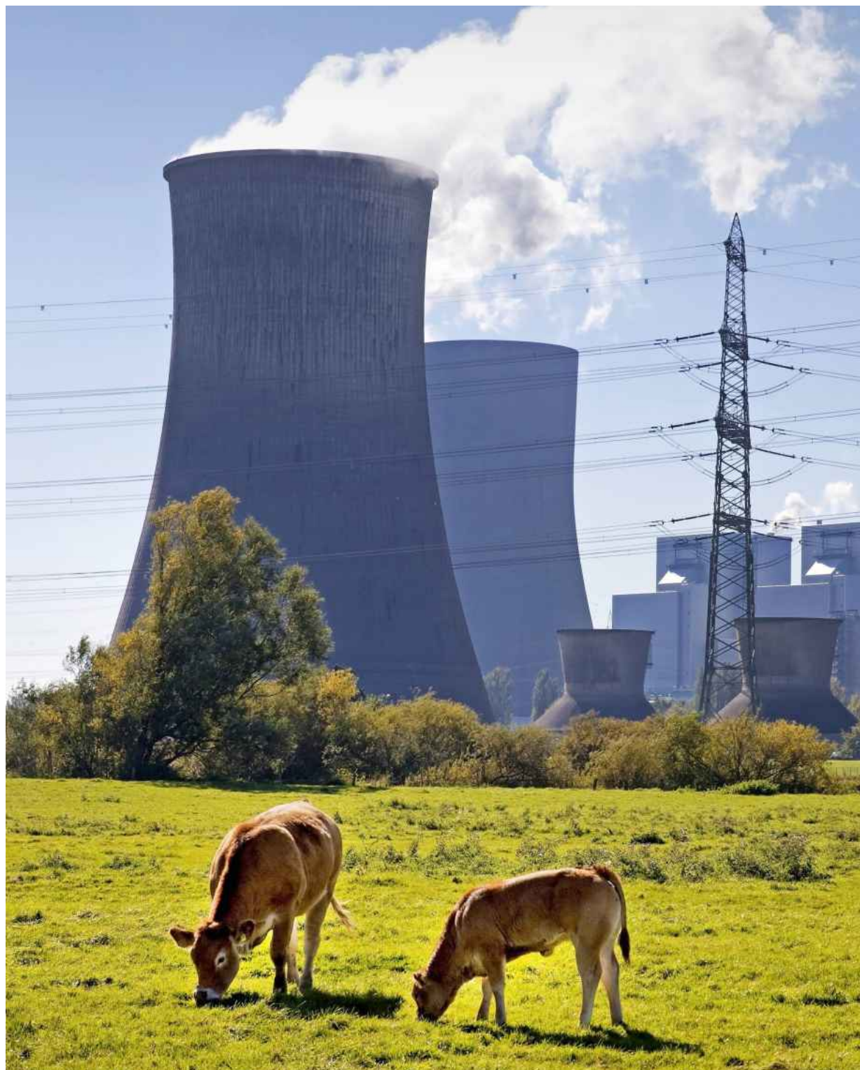
RWE-Kohlekraftwerk Westfalen – mit der Dekarbonisierung könnte Deutschland gleich zu Hause anfangen. Foto: imago/Blickwinkel
